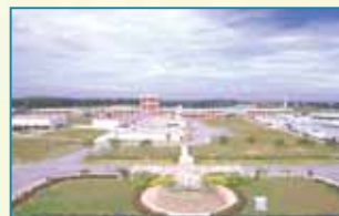
马来西亚吉隆坡Sungai Selangor 饮用水处理厂
